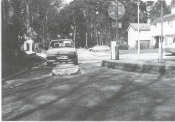
الصورة 15: حواجز عند مداخل خط الباص
