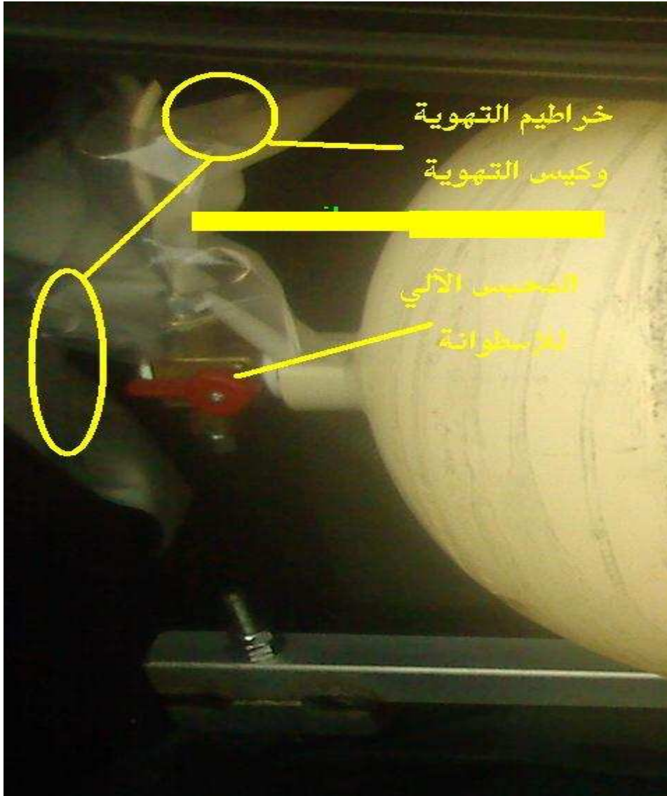
شكل (٢-٢) محبس الغاز الخاص بالاسطوانة وخراطيم التهوية وأنبوب الغاز
