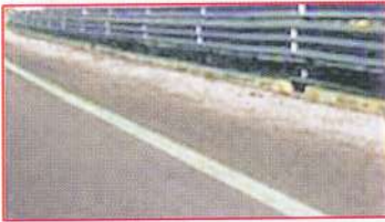
خط طرف الطريق يحدد الهامش المخصص للوقوف في حالات (الطوارئ) والذي يمنع السير ضمنه
